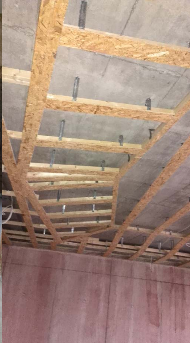
Trockenbau in Schömberg
