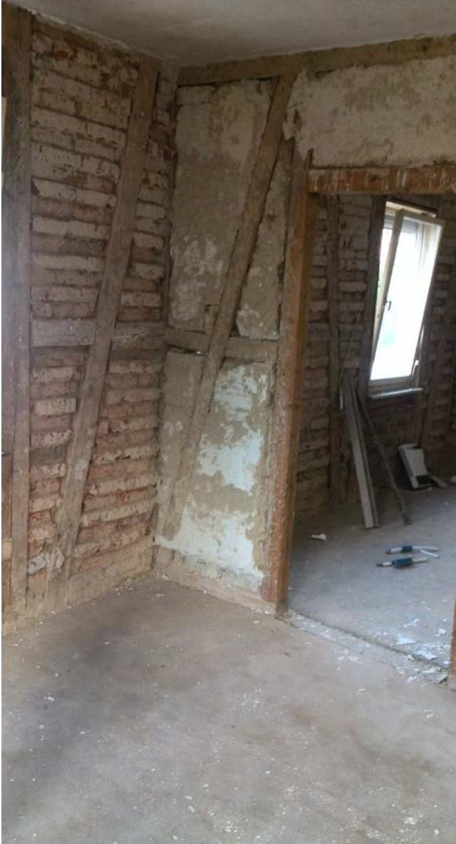
Privathaus Renovierung in Tuttingen
